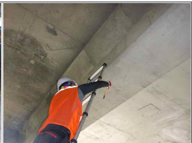
사다리를 이용한 근접조사(하부)
